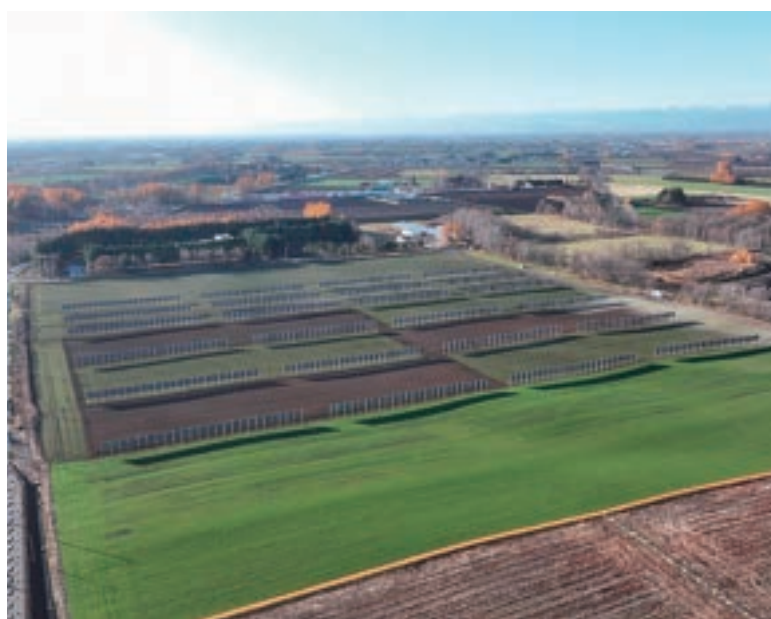
▲設備全体風景
