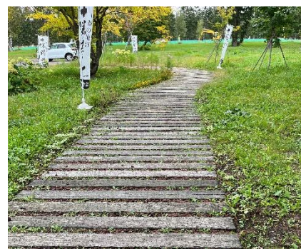
碧雲蔵駐車場から玄関までのアプローチ 枕木の間隔は約10cm
