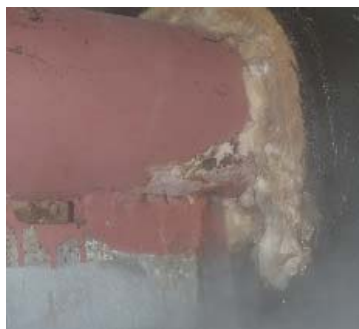
故障（漏れ）が頻繁に発生する蒸気ライン
