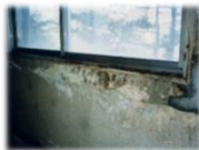
サッシの老朽除状況 (合宿棟)
