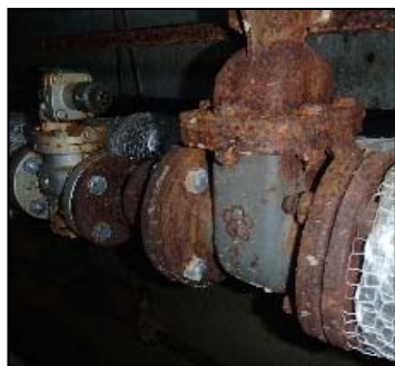
故障（漏れ）が頻繁に発生する蒸気ライン
