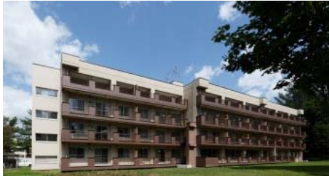
国際交流会館Ⅰ号館改修事業
