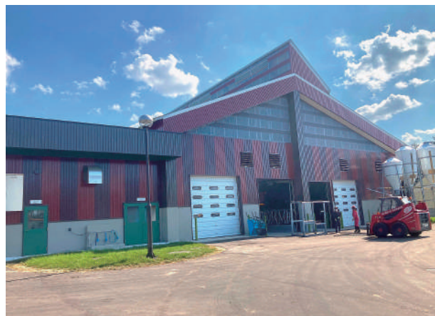
▲完成した新牛舎・搾乳舎の外観
