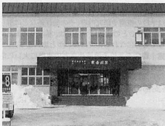
写真1; 家畜病院正面玄関
