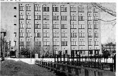
新築なった生物資源科学棟（家畜病院側から撮影）
