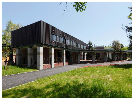
かしわプラザ外壁太陽光発電設備
