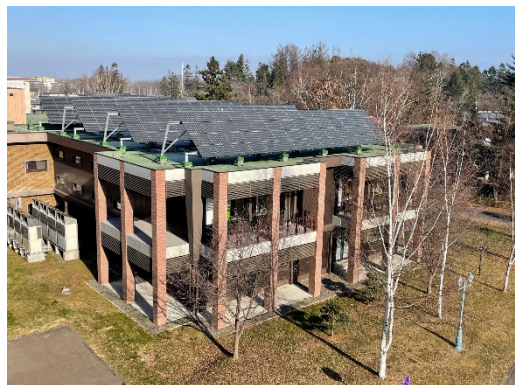
図書館屋上太陽光発電設備
