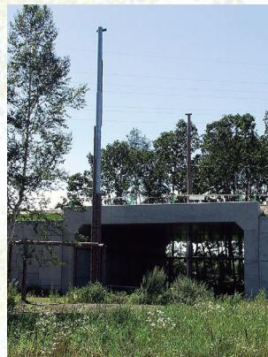
高速道路の建設に伴って生息地が分断されたエゾモモンガのため、帯広市内に設置されたモモンガ用道路横断構造物(通称:モモンガの橋)。
