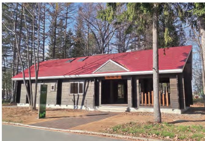
平成 23 年 10 月 追遥舎完成（外観）
