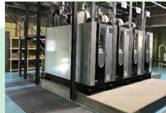
更新後 小型ボイラー（天然ガス）
