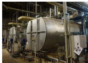
更新前 大型蒸気ボイラー（A重油）
