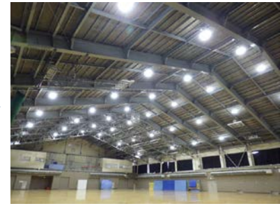
改修後（LED灯）
