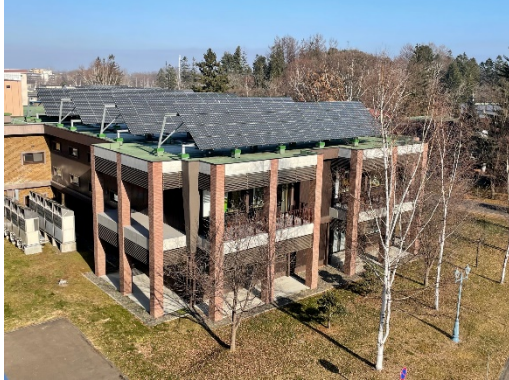
図書館屋上太陽光発電設備
