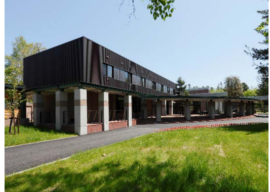
かしわプラザ外壁太陽光発電設備
