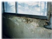
サッシの老朽除状況 (合宿棟)
