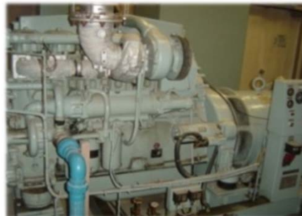
緊急時の対応として 非常用発電機の更新
