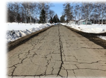
凍害による道路損傷
