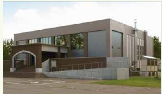
改修後の講堂
