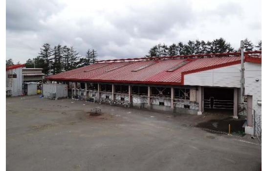
老朽化した畜産フィールド科学センター施設群
