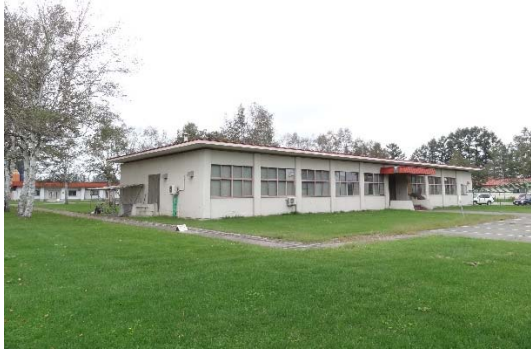
老朽化した畜産フィールド科学センター管理棟
