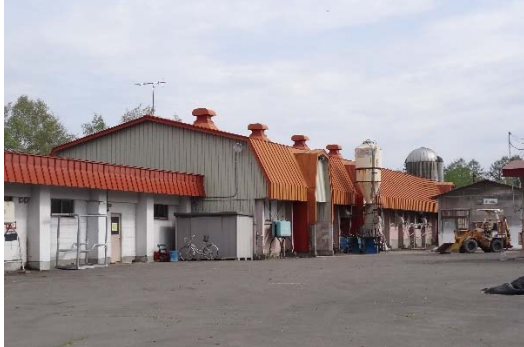
老朽化した畜産フィールド科学センター施設群
