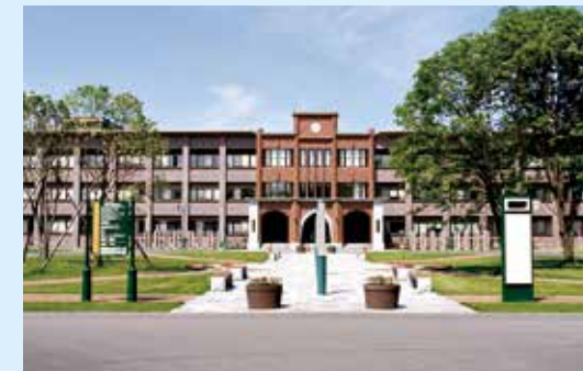
総合研究棟 I 号館
